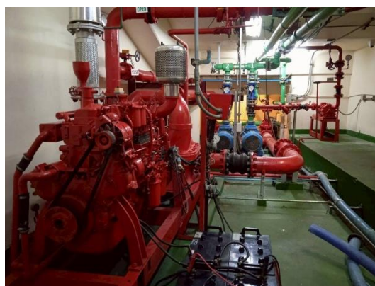
ภาพที่ 30 ปั๊มสูบน้ำดับเพลิง
